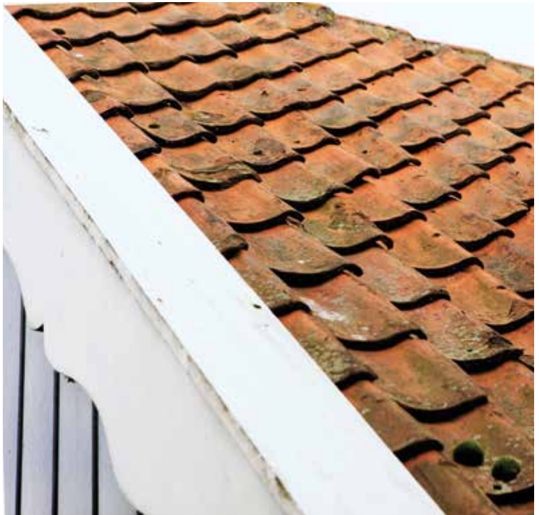
Dak met windveer en bedekking met gegolfde Hollandse pannen
