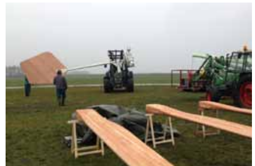
Voorbeeld kleine, houten windmolen van EAZ. Met een masthoogte van 15 meter en rotordiameter van 12 meter wekt deze molen gemiddeld 34.500 kWh/jaar op. Dit is voldoende voor een werf.
