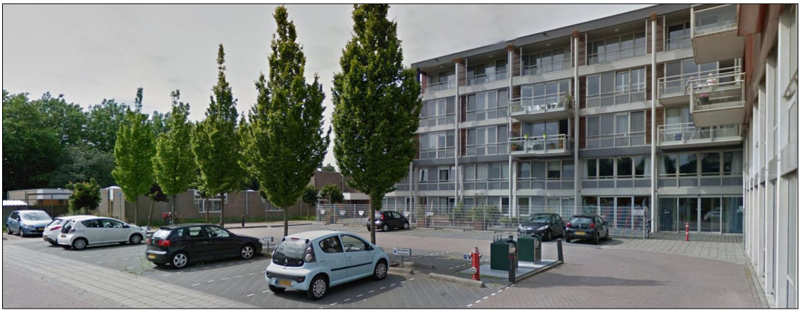
Figuur 8. Parkeerterrein De Werf met daaraan de brandweerkazerne met daarboven woningen
